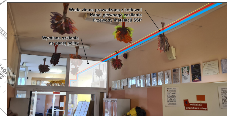
Panel SP.D.Ppoż.2 Wizualizacja przejścia rurami przez stolarkę aluminiową
